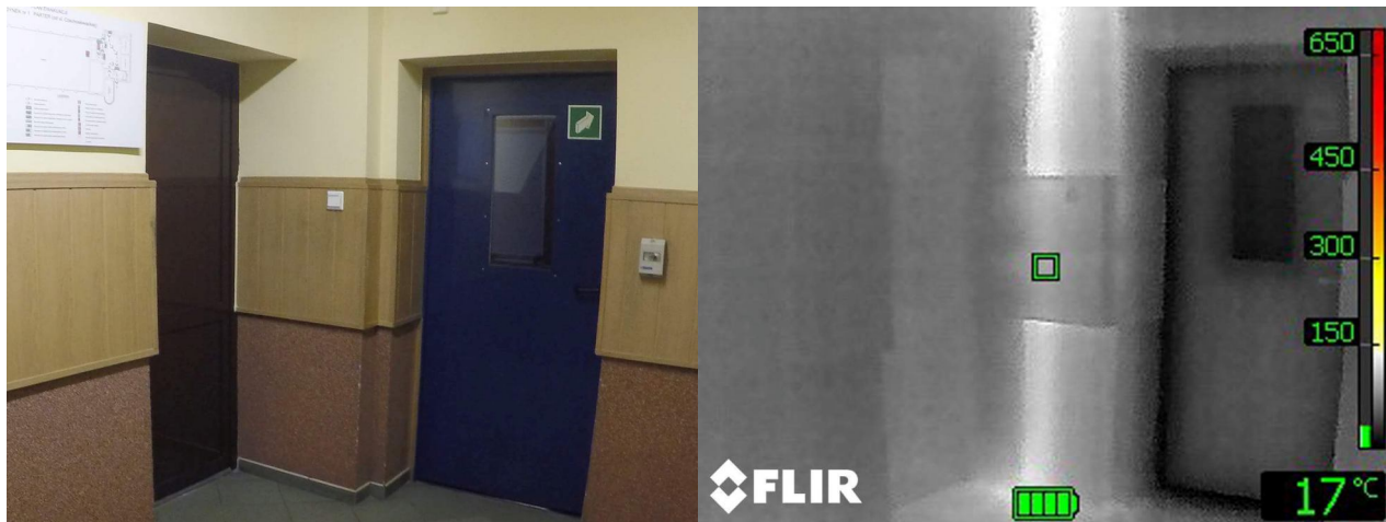
■ Fot. 38 i 39: Przykład zastosowania kamery do sprawdzania stopnia nagrzania przewodów kominowych.
