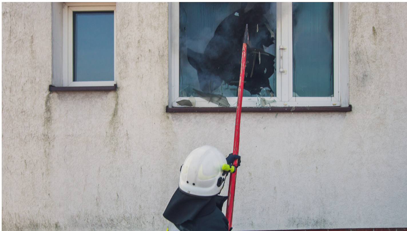
Fot. 22: Dowódca lub wyznaczona osoba wykonuje wylot gazów pożarowych.
